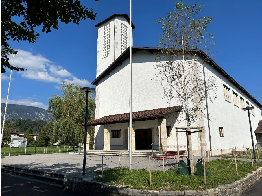
Abb. 1 Dreifaltigkeitskirche Bellach, Westansicht. Quelle Kirchgemeinde
